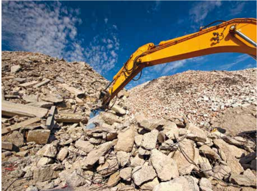
Abbildung 22: Gezielter Rückbau von Gebäuden als Voraussetzung für ein modernes Betonrecycling
