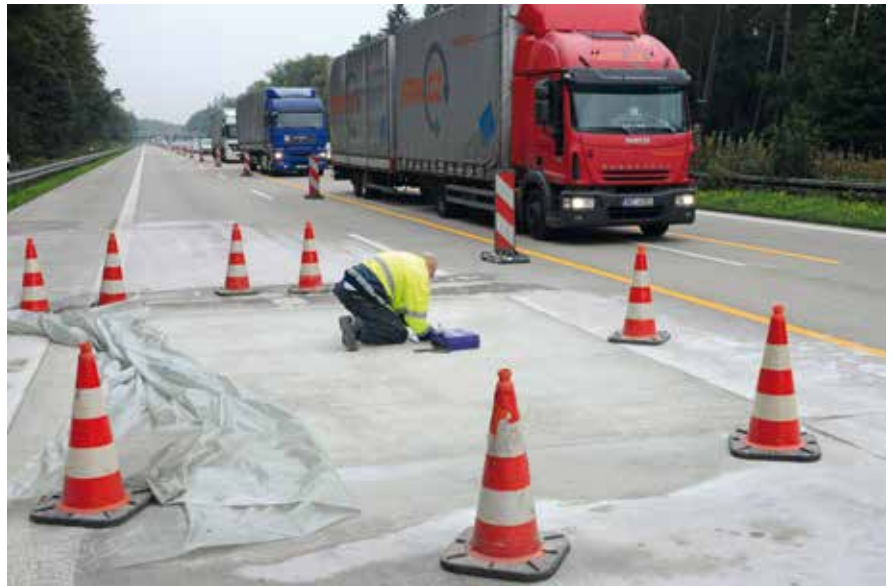
Abbildung 27: Reparaturen von Fahrbahndecken mit Hilfe von Spezialbetonen auf Basis schnell erhärtender Zemente
