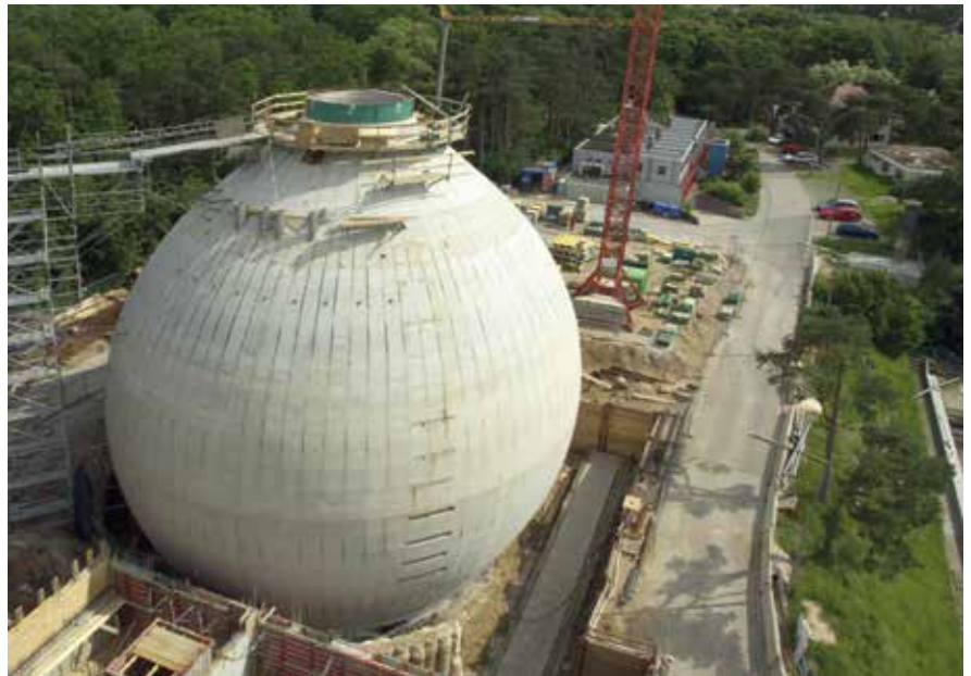
Abbildung 26: Beton als leistungsstarker Baustoff auch für besondere Anwendungen wie Faultürme in Kläranlagen
